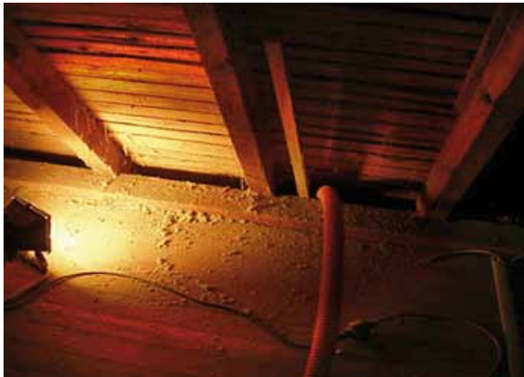
Dachschräge mit Hinterlüftung
